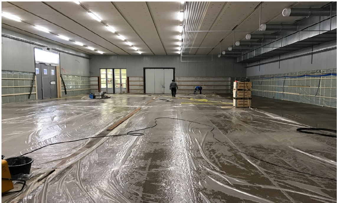
Bild 8. Fukthårdning med plastfolie.
