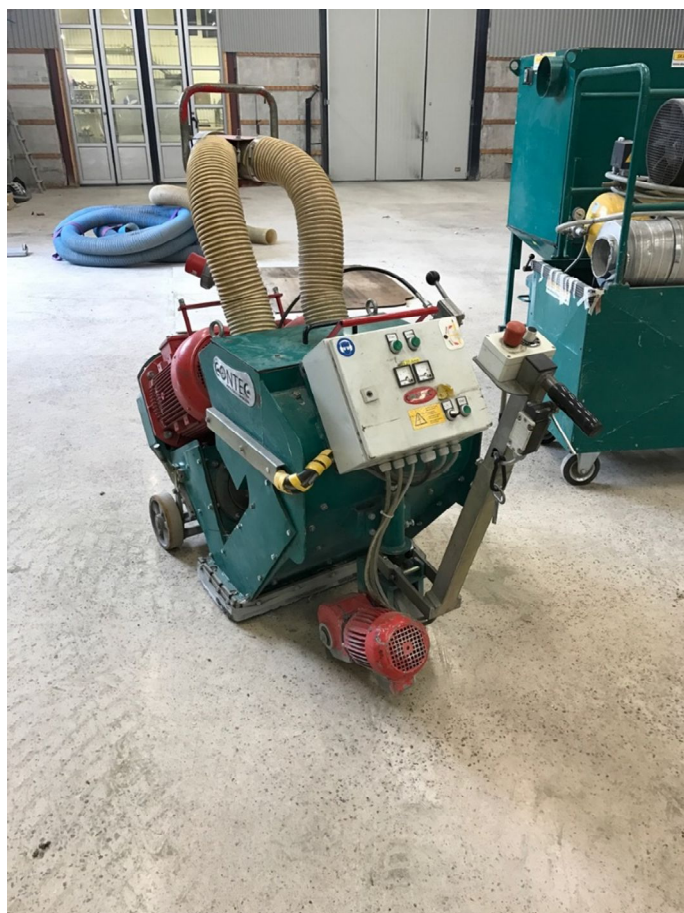
Bild 2. Stålkuleblästring av betonggolv.
