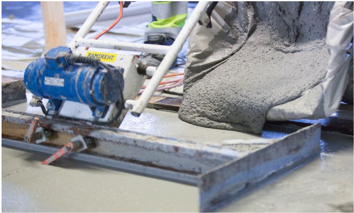
Bild 3 Kärning till vibrobalk.
