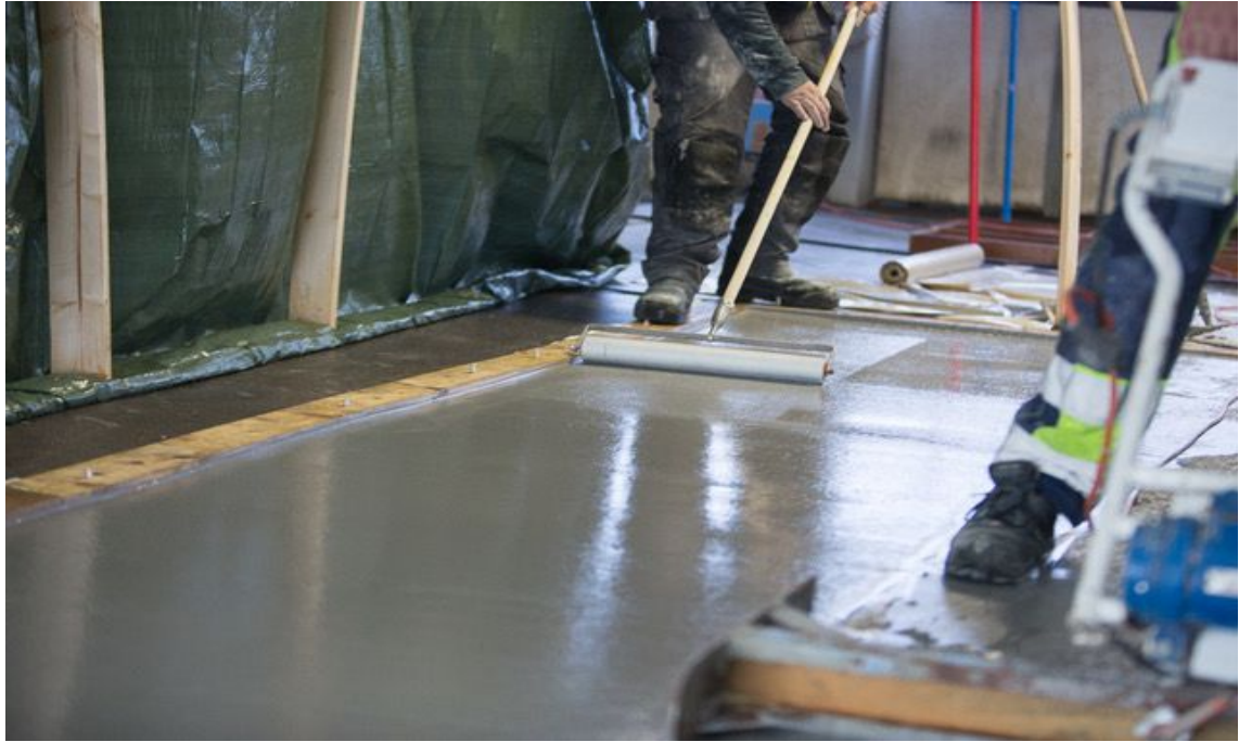
Bild 5 Piggrullning för jämnare yta.
