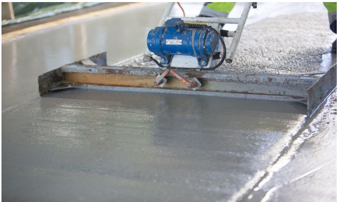
Bild 4: Utläggning med vibrobalk.
