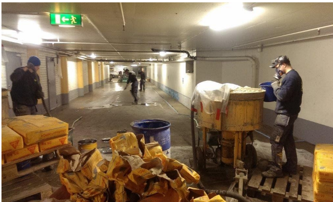
Bild 1: Blandning av säckad hårdbetong.
